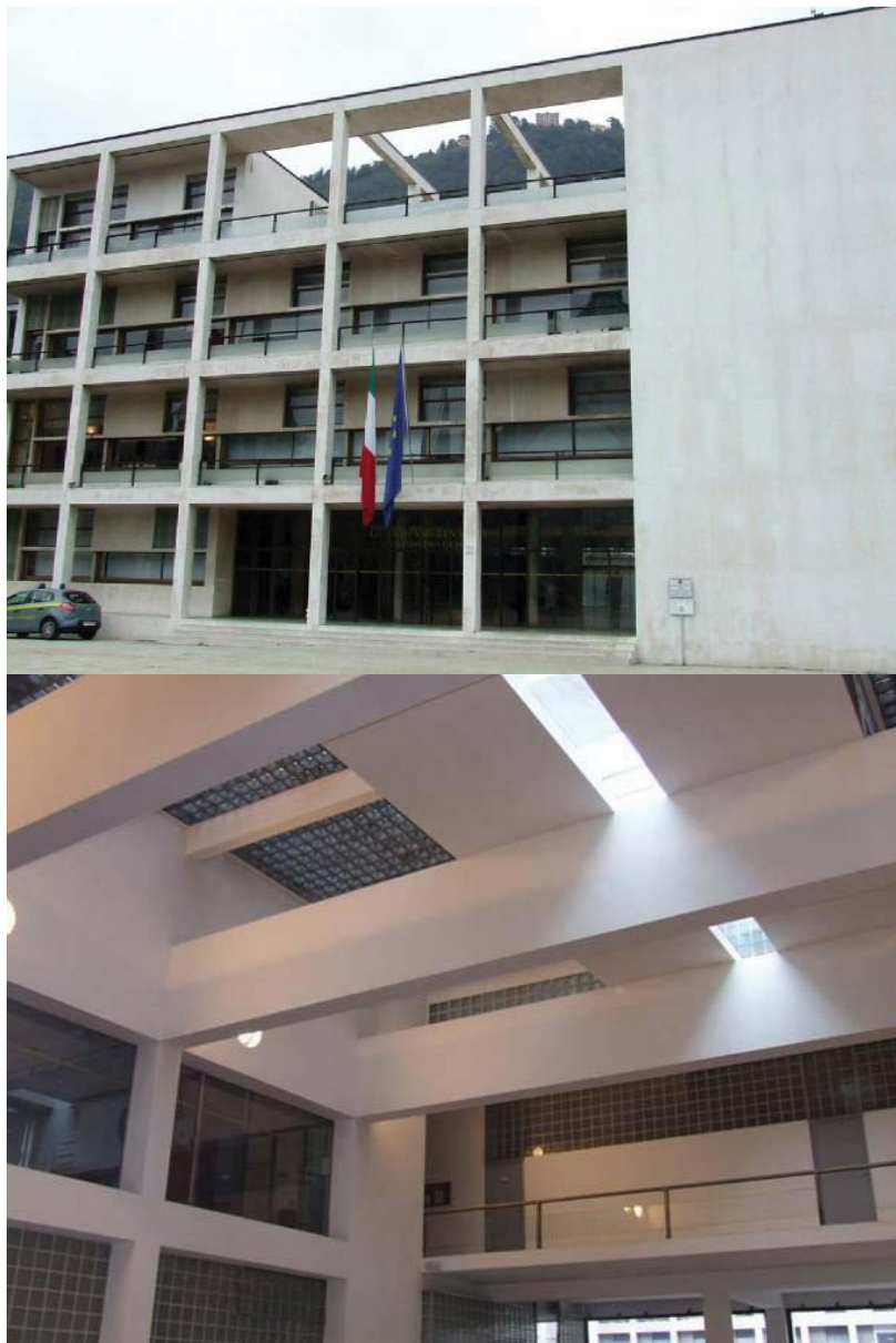
Fig. 125. Casa del Fascio, Photo: M. Bostenaru, 2009
