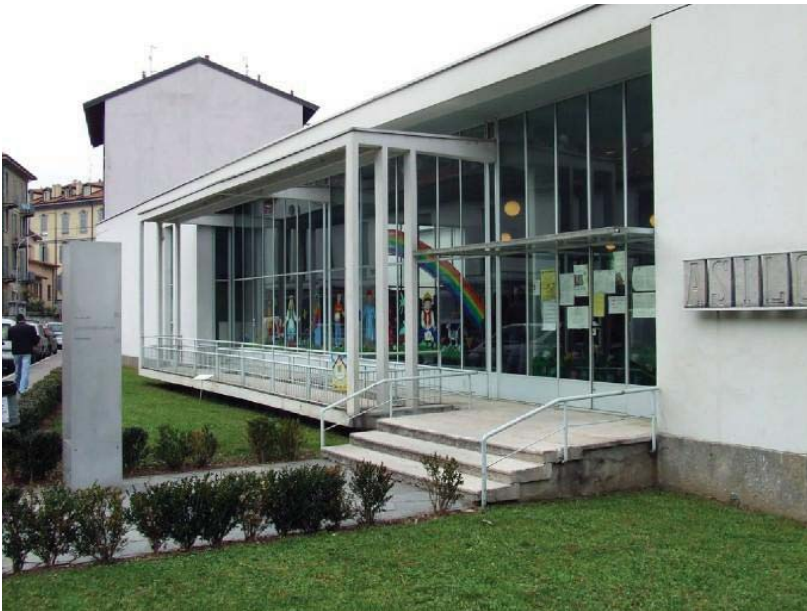
Fig. 123. Asilo Sant Elia, Photo: M. Bostenaru, 2009
