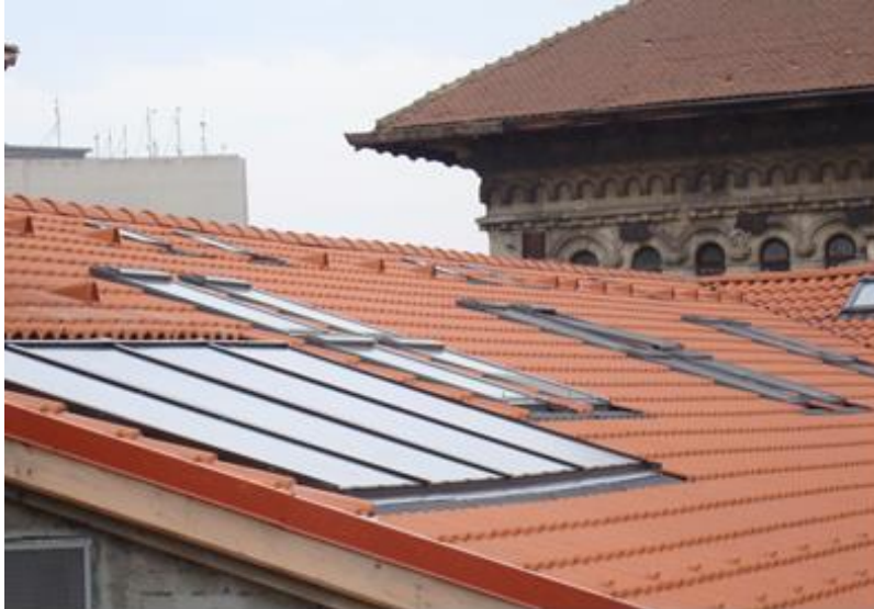
Fig. 4: "Coridorul solar" (Dabija, A-M 2016) al Universității de Arhitectură , panourile fotovoltaice și tunelurile solare
