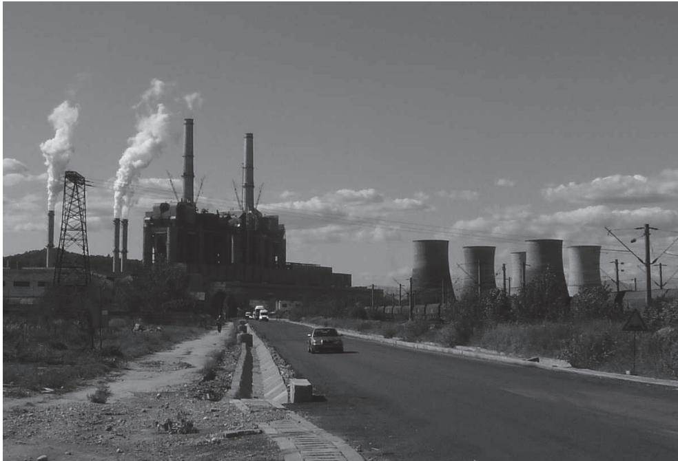
Fig. 29. Sursă industrială de degradare a mediului - termocentrala Rovinari Fotografie proprie, septembrie 2015
