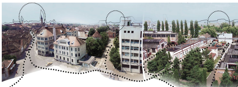
Fig 151 Imagine aeriană cu evidențierea amplasării sitului industrial „Uzinele Rieger-Independența” (regim de înălțime, repere urbane) 350
