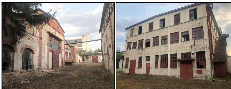
Fig. 176 și Fig. 177 - Imagini cu clădirile industriale istorice, respectiv Corpul D și Corpul C - Detalii de tartare a fațadelor 401
