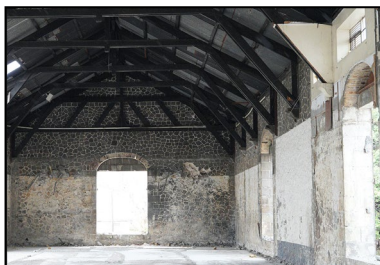
Fig. 42 Perspectivă interioară cu structura lemn și închideri exterioare din cărămidă la o clădire industrială 102
