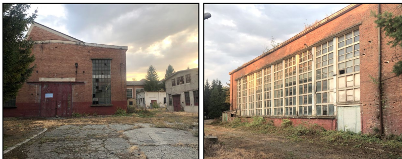
Fig. 178 și Fig. 179 - Imagini cu clădirile industriale istorice, respectiv Corpul J și Corpul G - Detalii de tartare a fațadelor 403
