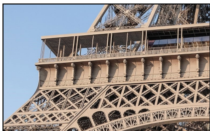
Fig.38 Ornamentele elementelor structurale ale Turnului Eiffel 99
