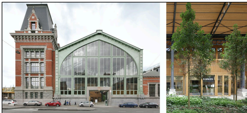
Fig. 118 Vedere exterior și interior a proiectului de reutilizare adaptivă Gare Maritime 273
