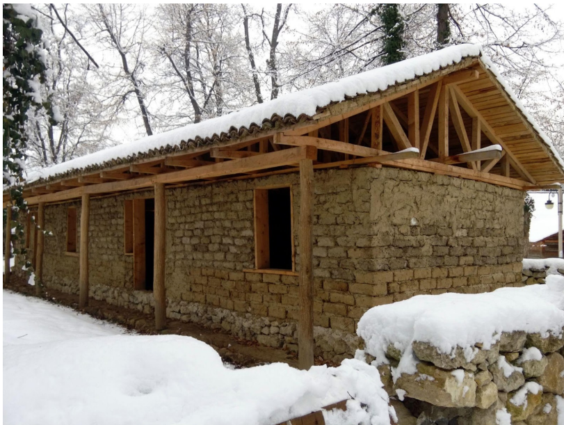
Fig. 5.4 Montarea elementelor din lemn în zidaria de chirpici la Muzeul Satului “Dimitrie Gusti” din București
