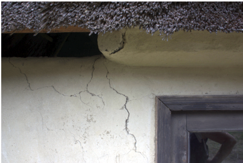
Fig. 5.3 Crăpături apărute în tencuiala din pământ în Muzeul Național al Satului „Dimitrie Gusti” București
