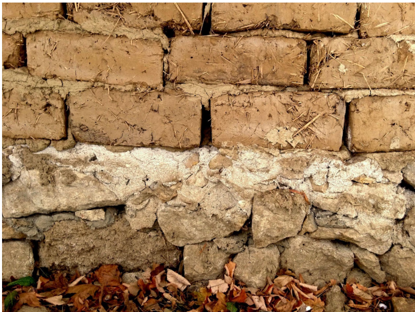
Fig. 5.5 Zidărie din chirpici așezată direct pe fundația din piatră
