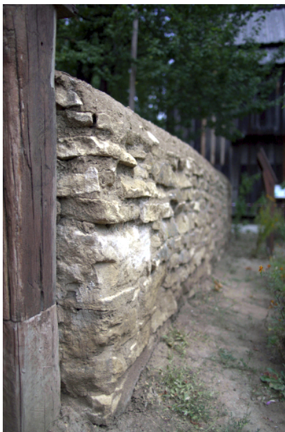
Fig. 2.4 Gard realizat din piatră și mortar din ceamur în Muzeul Național al Satului „Dimitrie Gusti” București
