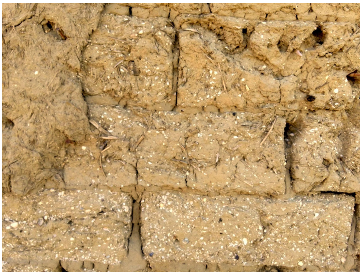
Fig. 2.3 Peste zidăria de chirpici se realizează primul strat de tencuială
