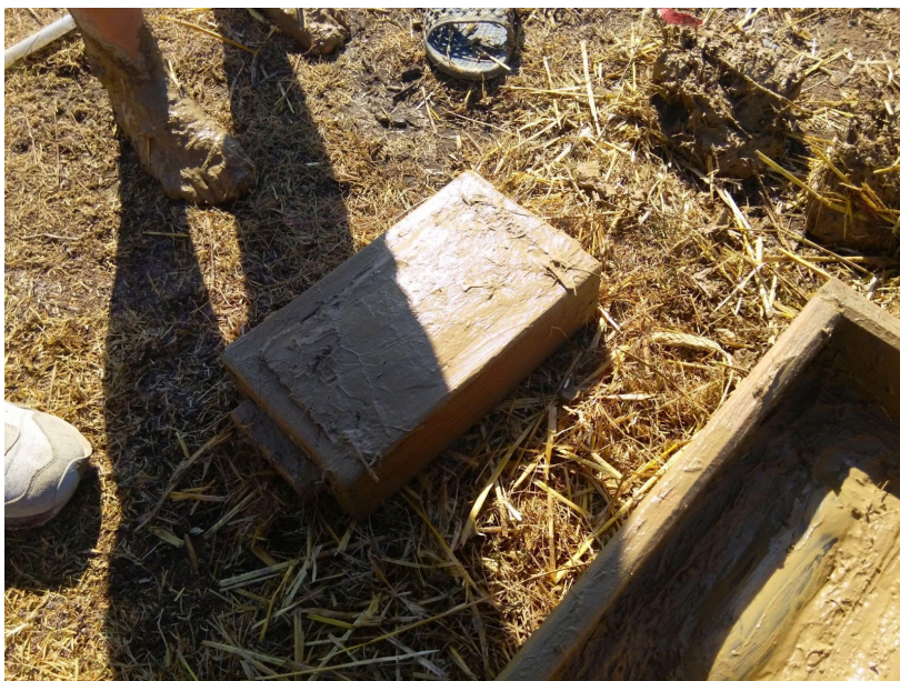
Fig. 5.1 Realizarea chirpiciului în matrițe de lemn
