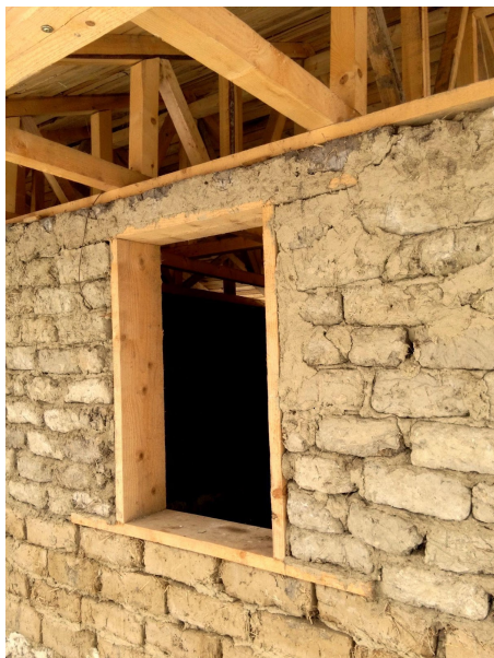
Fig. 3.4 Zidarie din chirpici în timpul construcției
