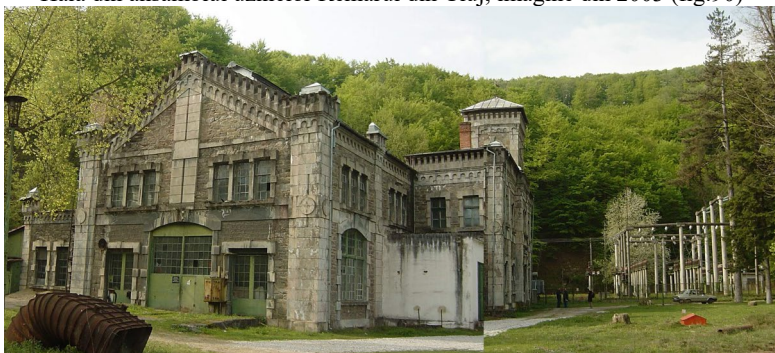
Centrala electrică Grebla din Banatul montan, imagine din 2007 (fig.91)
