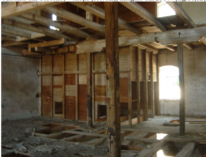
Moara Olmazu din București - interior, imagine din 2007 (sec. XIX) (fig.83). Spațiul multietajat realizat integral cu ajutorul stâlpilor și grinzilor din lemn o făcea să fie unică din punct de vedere al structurii printre puținele mori tradiționale rămase în București la acea dată.
