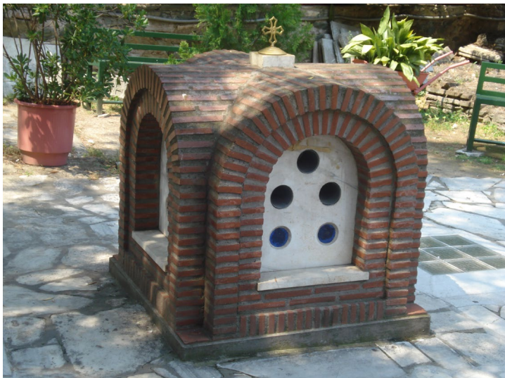
Corp de desfumare amplasat deasupra unei biserici-catacombe (Sf. Ioan) în care se aprind lumânări - Salonic, Grecia (perioada creștină timpurie)
