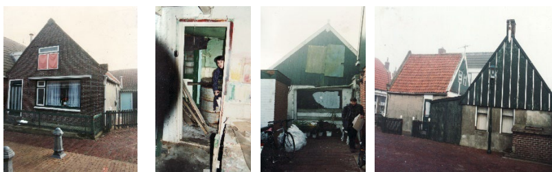
Fig.V. 6 - Ansamblul celor trei locuințe de pescari din sec.al XIX-lea, înainte de restaurare
