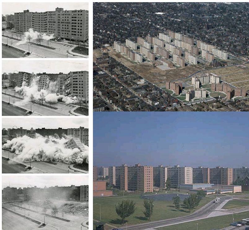
Fig.V.29 – Ansamblul Pruitt Igoe, arh. Minoru Yamasaki, construit între 1951 - 1955 în St. Louis, Missouri, Statele Unite, demolat între 1972 - 1976
