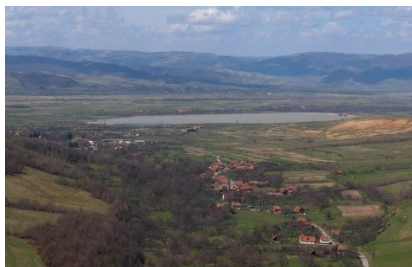
Fig.VII.26 – Barajul de la Ostrov
