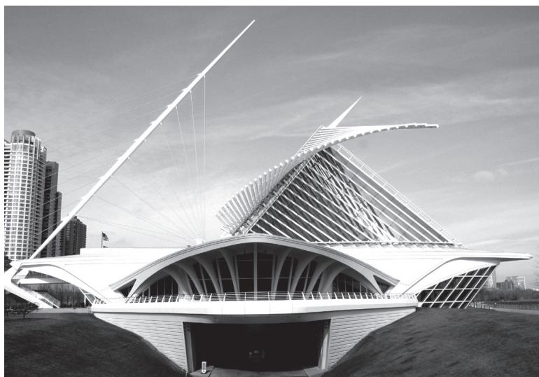
Fig. 3.16_ Muzeul de Artă Milwaukee, Pavilionul Quadracci, Wisconsin, SUA, 2001, arhitect Santiago Calatrava
