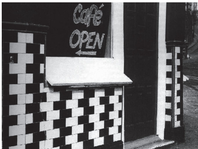
Fig. 1.26_ Modul de dispunere a plăcilor ceramice pe peretele de la cafeneaua din St. Michael's Hill, Bristol, dă imaginii de ansamblu un caracter dinamic.
