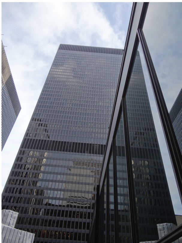
2.19. Federal Plaza, Chicago, van der Rohe, 1974 sursă pentru Burgo Tower
