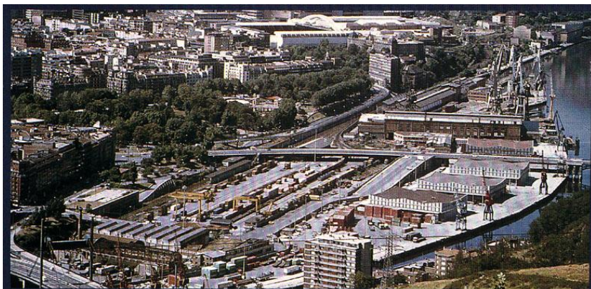
Situl înainte de interventie
