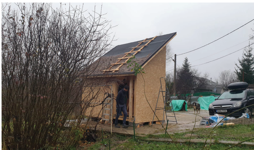
Fig. IV. 107-108-109 Imagini montaj ecomodul pe sit, octombrie/noiembrie 2019, sursa arhiva personală, închideri perimetrale cu OSB pentru protecția stratului de vată minerală. Peste acesta urmează stratul exterior al anvelopei.
