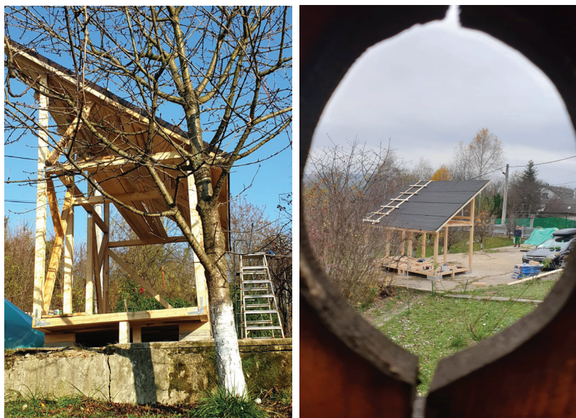
Fig. IV. 107-108-109 Imagini montaj ecomodul pe sit, octombrie/noiembrie 2019, sursa arhiva personală, închideri perimetrale cu OSB pentru protecția stratului de vată minerală. Peste acesta urmează stratul exterior al anvelopei.
