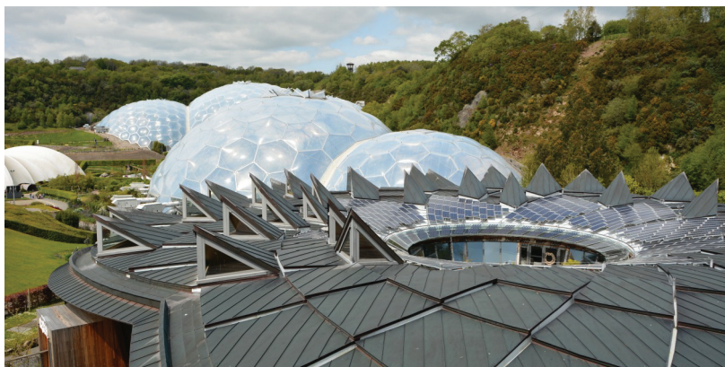
Fig. III.11 Clădirea expozițională Core cu elemente de ventilare naturală și fotovoltaice, arhiva arh. Mihai Man
