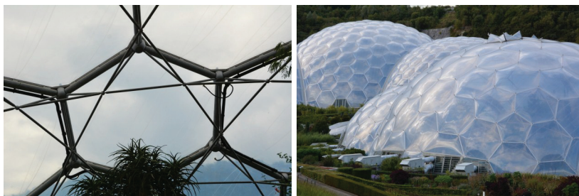
Fig. III.8-9 – Forme hexagonale ale structurii și volumelor bioamelor Eden, consum minim de material cu performanță structurală, sursă arhiva arh. Mihai Man
