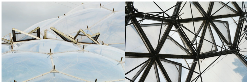
Fig. III.17-18 – Ventilare naturală exterior (stânga) și interior (dreapta), arhiva arh. Mihai Man
