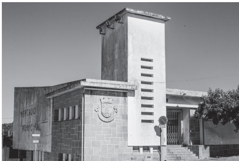
Fig. 223. Mercado Municipal (Piața municipală) din Sertão, Arh. Cassiano Branco (1927). Fațada principală; sursa: internet
