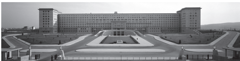
Fig. 165. Spitalului Universitar Santa Maria, Lisabona, Arh. Hermann Distel și João Simões (1953); foto: Mario Novais, sursa: https://gulbenkian.pt/biblioteca-arte/en/collections/galerias-e-exposicoes/photos-with-history/santa-maria/ (FCG)
