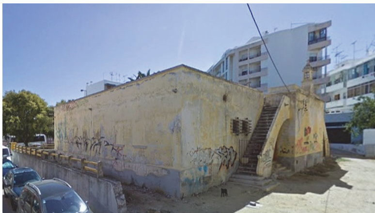
Fig. 232. Grémio dos Conserveiros do Sotavento Algarvio , Arh. Fernando Coruche (1945); sursa: Google Streets
