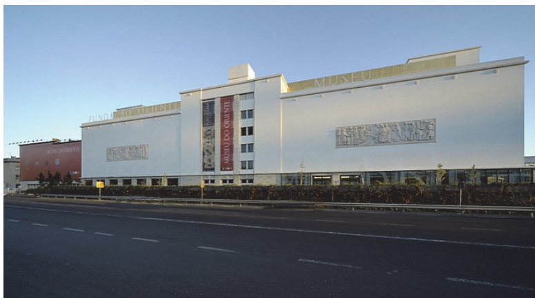
Fig. 219. Armazens Frigoríficos (depozitul frigorific) din Alcântara, Arh. João Simões (1950); foto: Arh. Sorin Vasilescu
