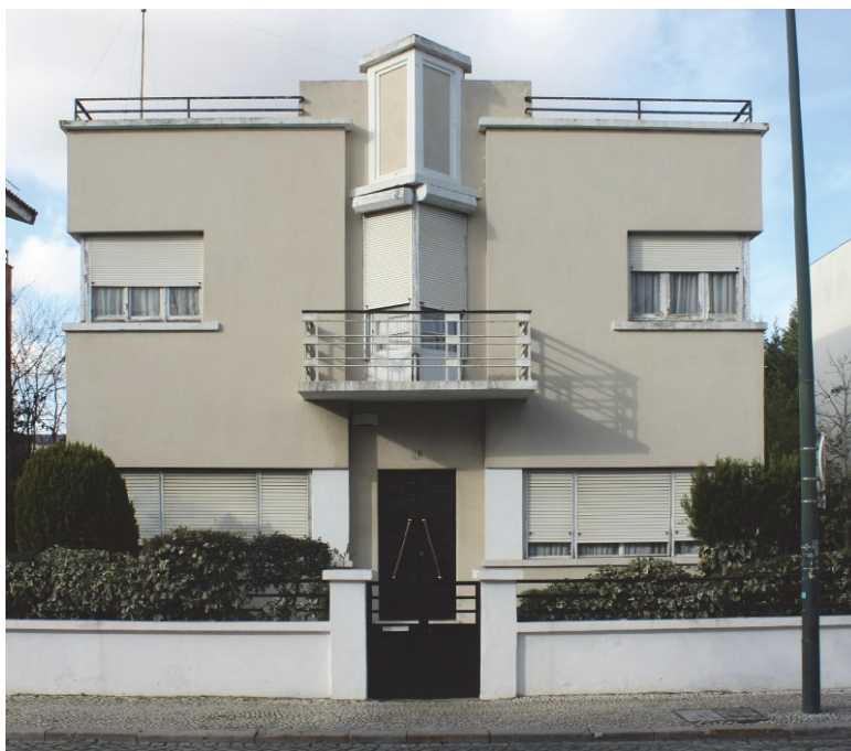
Fig. 261. Locuință unifamilială, Avenida António José de Almeida no. 16, Arh. Cassiano Branco (1933)
