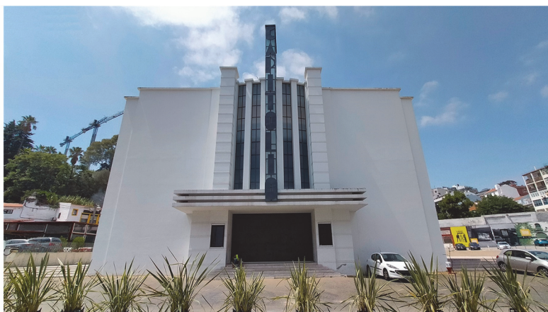
Fig. 167. Cineteatro Capitólio , arh. Luís Cristino da Silva (1931), fațada principală
