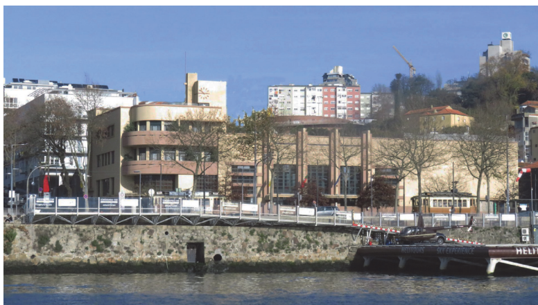
Fig. 218. Armazéns Frigoríficos de Massarelos (Depozitele Frigorifice din Massarelos), Porto, Arh. Januário Godinho (1934)
