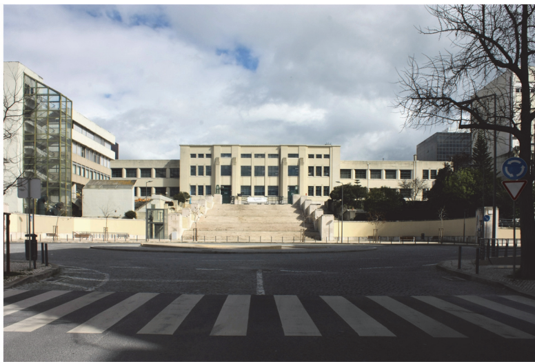
Fig. 135. Institutul Superior Tehnic, Lisabona, Arh. Porfírio Pardal Monteiro (1931); Fațada Vestică
