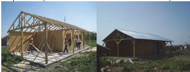
Figura 74 Deși contractul cu antreprenorul prevedea turnarea a doar cca 40mp de placă, beneficiarii locuințelor au echivalat suplimentarea de 20mp cu manoperă de săpătură în spații limitate la fundații și prepararea și turnarea betonului. Imagini din Sărulești și Dor Mărunt, aprilie și mai 2012.
