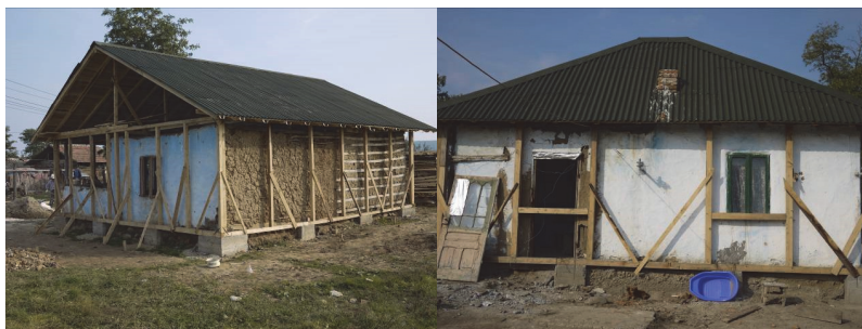
Figura 70 Locuințe în Bălțești (jud. Prahova), cărora le-a fost înlocuit acoperișul fără strămutarea familiei. 2010
