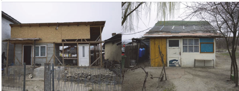
Figura 73 În general, în comunitățile afectate de sărăcia extremă, construcțiile utilizează pe scară largă materiale refolosite. În Podenii Noi (Prahova), am întâlnit însă o măiestrie locală în a pune în operă aceste materiale. Cele două construcții de mai sus dovedesc un meșteșug bine stăpânit și chiar o estetică a fațadelor.
