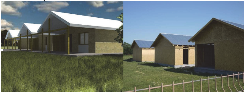
Figura 59 Centrul social din Dor Mărunt. În stânga proiectul inițial al Arhipera. În dreapta, fotografie de șantier din 13.06.2012.
