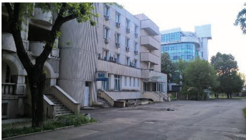
Foto Brăila 14 - Hotel și sediul BTT în clădirea casei de cultură; Sursa: personală, mai 2016
