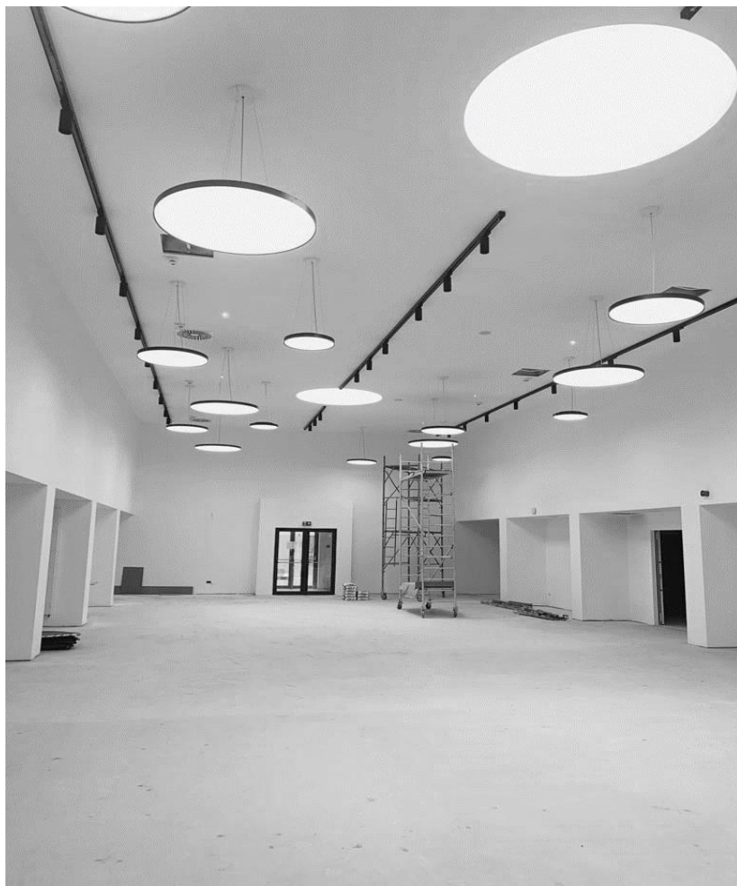
Figura 39 - Fotografie șantier, sala de mese
