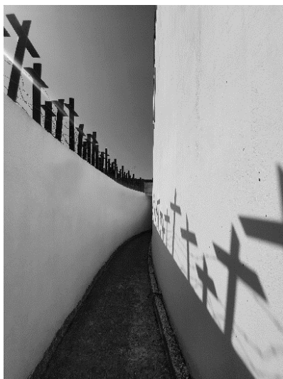
Fig. 71. Rampa descendentă dintre cele două ziduri
