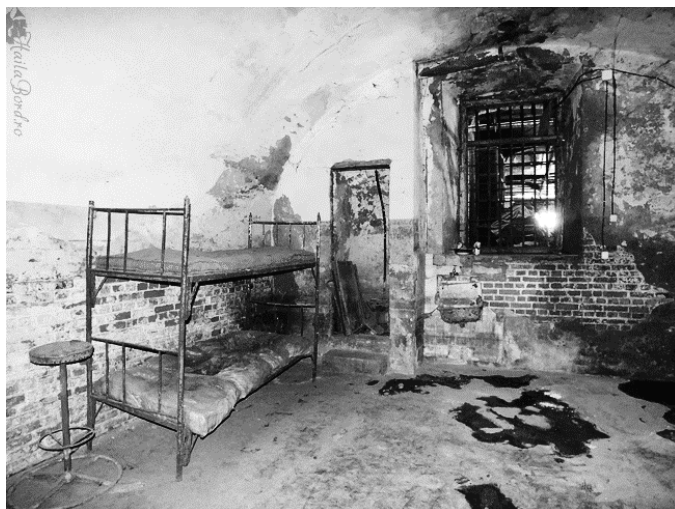
Fig. 21. Interior de celulă – Jilava
