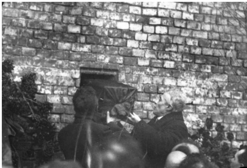
Fig. 27. Imagine de la plasarea unei urne în interiorul Zidului Kremlinului
