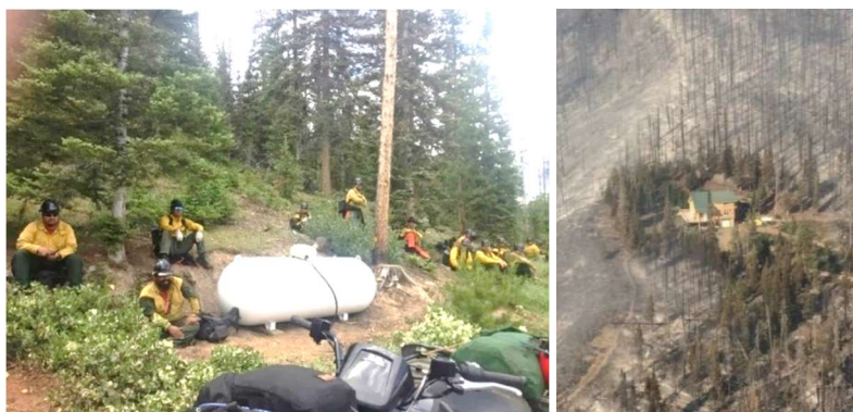
Fig. 8.29. Cabană salvată de la incendiu (Beaver Creek Fire Aug. 2016) prin luarea unor măsuri de prevenire: stropirea cu apă de către pompieri în jurul proprietății, înlocuirea învelitorii cu o învelitoare din tablă, tăierea unor arbori aflați în vecinătatea casei. © Nat Fay 203
