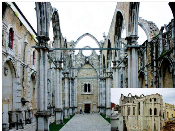
Fig. 4.20. Mănăstirea Carmo Convent, având acoperișul distrus după seismul de la 1755, astăzi Muzeul arheologic Sursa: https://www.earthmagazine.org/article/benchmarks-november-1-1755-earthquake-destroys-lisbon
