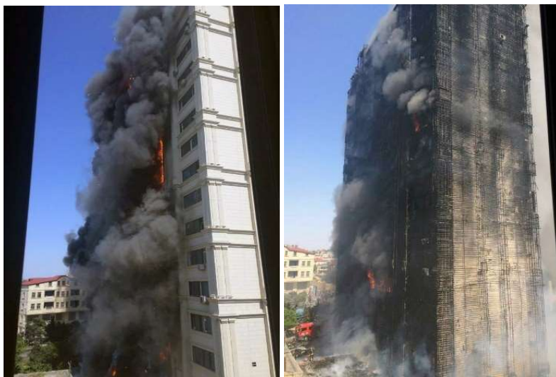
Fig. 9.7 Incendiu la sistem de fatada Baku, Azerbaijan
