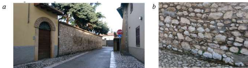
Fig.A3.3. (a) Materiale locale: piatră, cărămidă, gresie, pavaj; (b) Detaliu din zidărie confecționat din materialele reutilizate Sursă: © Stefania Trifan, 2018
