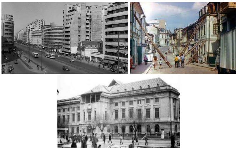
Fig. 5.12. – Centre urbane care au fost afectate de cutremur - Stânga București blocul Scala înainte de seism © Agerpres https://b365.ro/povestea-blocului-scala-din-bucuresti-cum-au-fost-condamnati-la-moarte-locatarii-sai-la-cutremurul-din-1977-511959/ , Craiova 93 , jos Ploiești – Palatul Culturii avariat https://www.zdp.ro/au-trecut-46-ani-de-la-cutremurul-din-4-martie-1977-foto-cu-efectele-din-prahova.html
