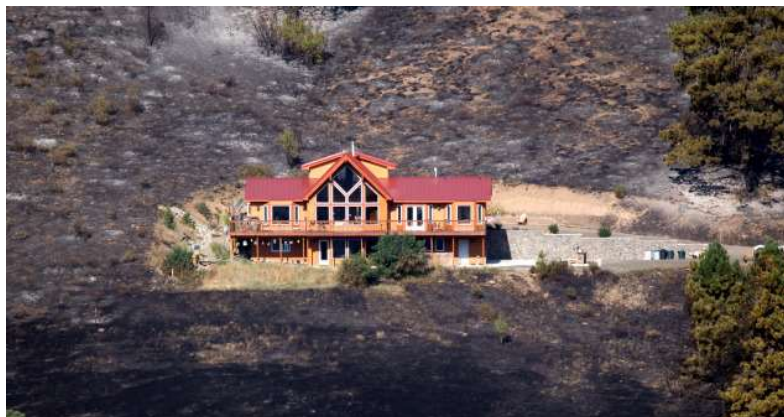
Fig 8.28. Construcție care a rezistat incendiilor de vegetație prin luarea măsurilor (fără copaci în jurul casei, păstrarea unei peluze cu iarbă verde și înlăturarea vegetației uscate lângă casa) 202 15 Aug. 2012, Cle Elum, Washington. (© Elaine Thompson)
