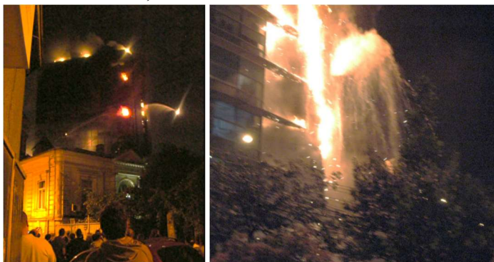
Fig. 5.16. Stânga - Fotografie cu fațada incendiată spre Biserica armenească realizată de la intersecția străzii Rafael Sanzio cu Strada Armenească; Dreapta – imagine cu panou și fragmente desprinse de la fațadă
