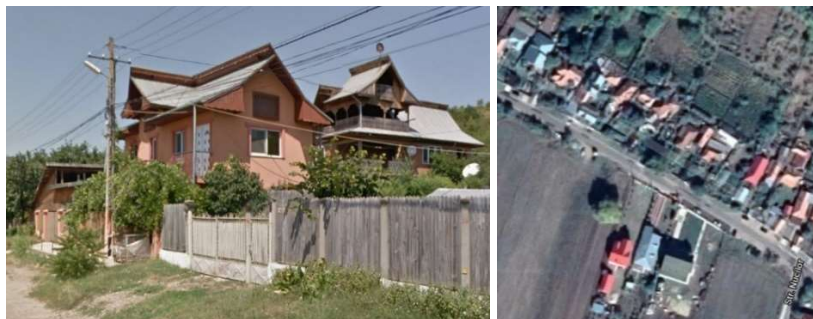
Fig. 8.18 Locuințe construite la distanțe mici, cu plăcări din lemn și structura acoperișului sprijinită pe stâlpi din lemn cu secțiune redusă; 171
