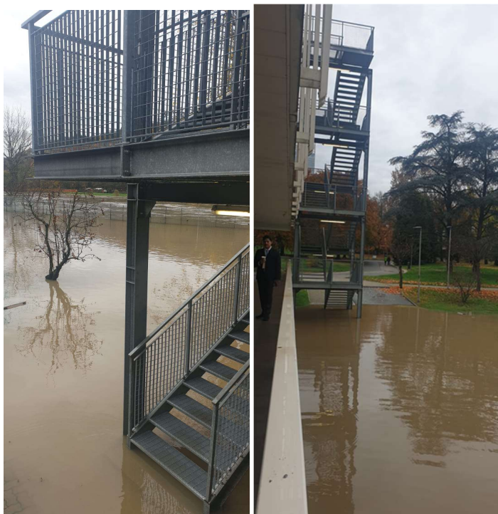
Fig. 7.13. Scară de evacuare exterioră inundată la partea inferioară © Mr. Petre Hurezanu 134
