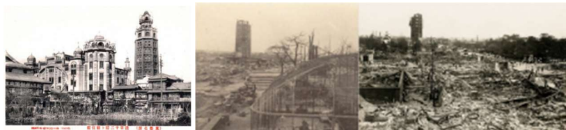
Fig. 4.33. Imagini înainte și după marele seism Kantō - Ryōunkaku sau Turnul care depășește norii a fost primul zgârie-nori în stil occidental al Japoniei. Construit în cartierul Asakusa din orașul Tokyo (acum Taitō, Tokyo) din 1890 acesta a fost demolat după cutremurul Marele Kanto din 1923.
