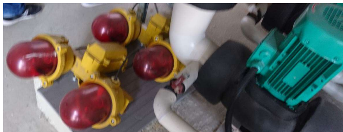
Fig.A2.3 Luminile de semnalizare pentru marcarea pe verticala a clădirii înalte sunt stocate în interior, deoarece clădirea nu este alimentată cu energie electrică
