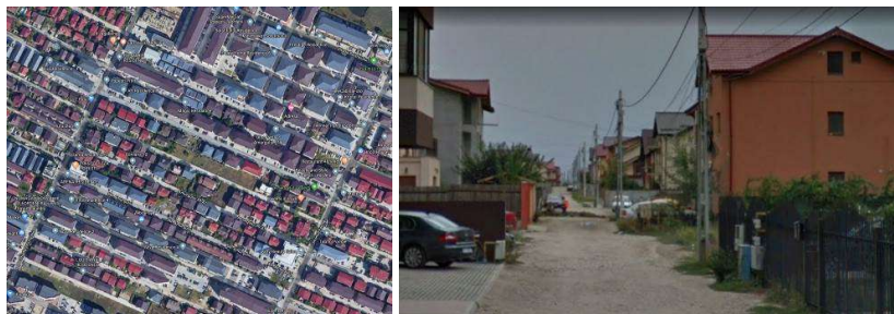
Fig. 5.11. – Zona rezidențială cu densitate mare Sursa Google. Imagine cu strada Amurgului Popești-Leordeni, județul Ilfov. Străzile înguste neasfaltate (6-7m lățime) care pot fi ușor blocate de lucrările de construcții sau de mașini reprezintă un risc de incendiu pe scară largă.
