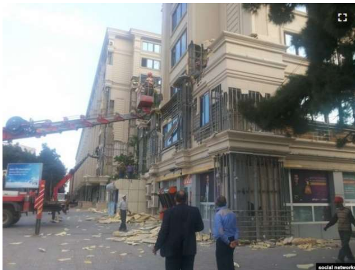
Fig. 9.8. Operațiuni de îndepărtare a termoizolațiilor de la fațade 223 © Daisy Sindelar
