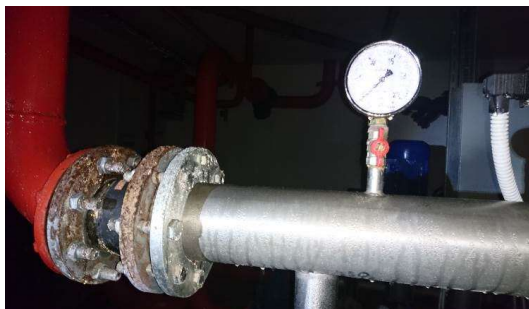
Fig. A2.7. Presiunea este 0, deoarece pompele nu funcționează
