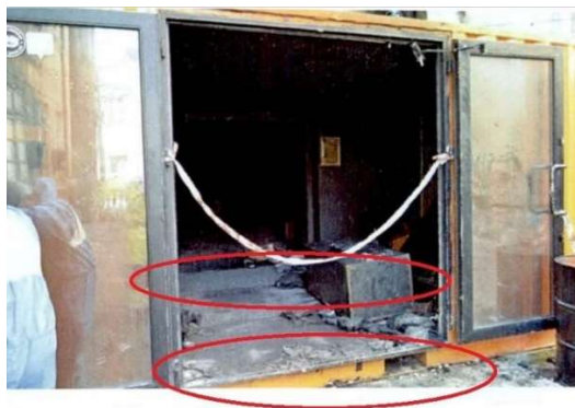
Fig.5.22. Praguri la trecerea prin container si element care obstrucționează calea de evacuare.
