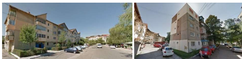
Fig. 8.16 Construcții rezidențiale regim de înălțime P+3E, P+4E, (mansarde improvizate, termoizolații parțiale fără a se cunoaște certificarea acestor materiale termoizolante) 169
