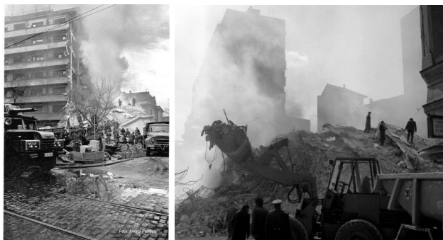
Fig. 5.10. – Intervenție dificilă pentru stingerea incendiilor - accesul mașinilor de pompieri a fost îngreunat din cauza molozului rezultat de la imobilele prăbușite în urma seismului
