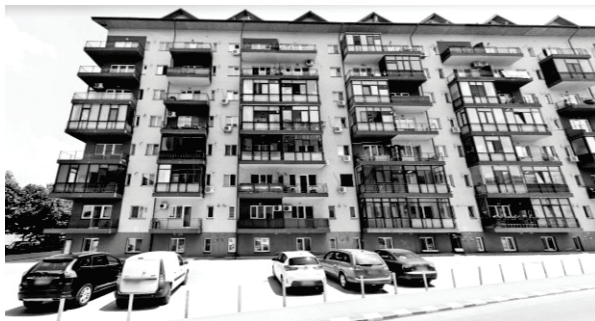
Figura 7.11. Studiul de caz Militari Residence. Exemplu de mărire a CUT-ului efectiv prin închiderea balcoanelor și extinderea suprafeței utile a apartamentului. Sursa: Google Street Map.
