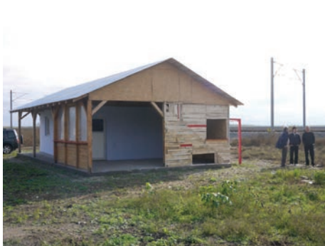
Casa de la calea ferată / The Railway House
