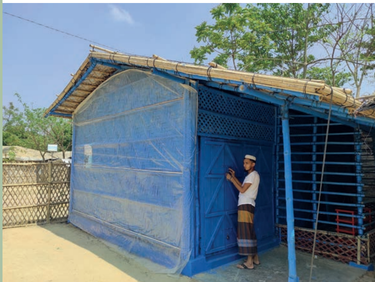
Construcție 4. Extindere. Structură pe un singur nivel. (Sus) Muncitor care fixează structura acoperișului în timpul lucrărilor de renovare. (Jos) Centru de învățare după renovare, îngrijit de un îngrijitor din comunitatea Rohingya. / Camp -4 Extension:
